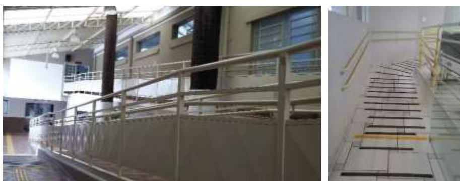
Figura 171 - Rampa de Acesso e (BC. - Piso 03 e BCU)
