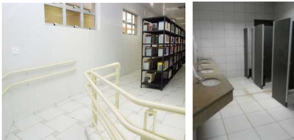
Figura 190 - Banheiros Coletivos e Rampa de Acesso ao Acervo (BCU)
